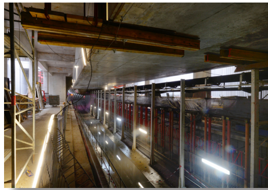
Novembre 2015 - Station Cleunay - Niveau quais
