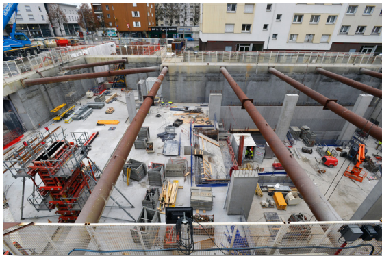
Novembre 2015 - Station Cleunay - Niveau salle des billets
